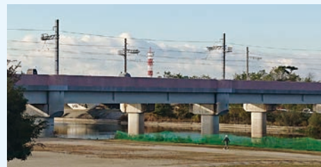
武庫川に架かる阪急神戸線（北側から）
